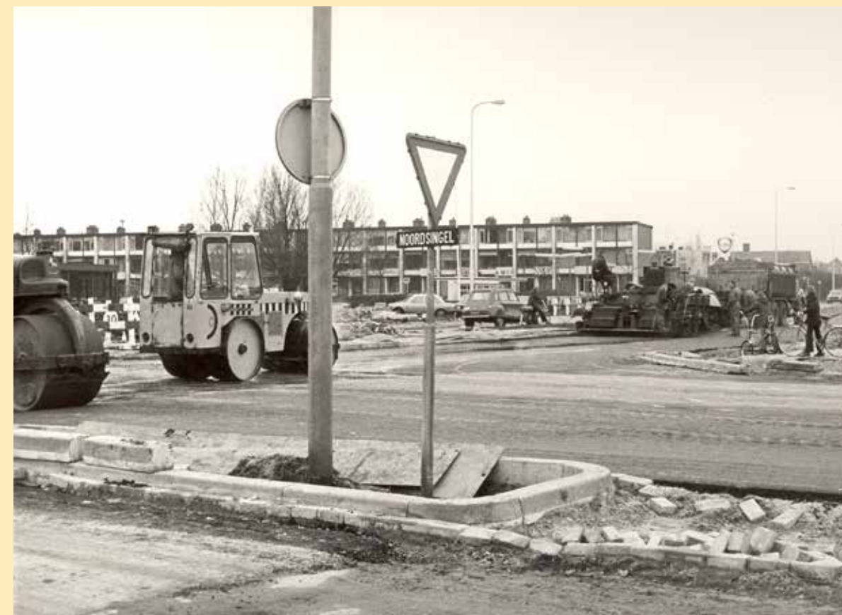
Reconstructie en asfaltering van de J.S. Bachlaan tussen de Noordsingel en Van Ruysdaellaan en de aanleg van een gedeelte van de Noordsingel, gezien vanaf de Noordsingel in de richting van de Van Ruysdaellaan. In het midden het FINA- benzinstation in 1975. Bron: Gemeentearchief Leidschendam-Voorburg
