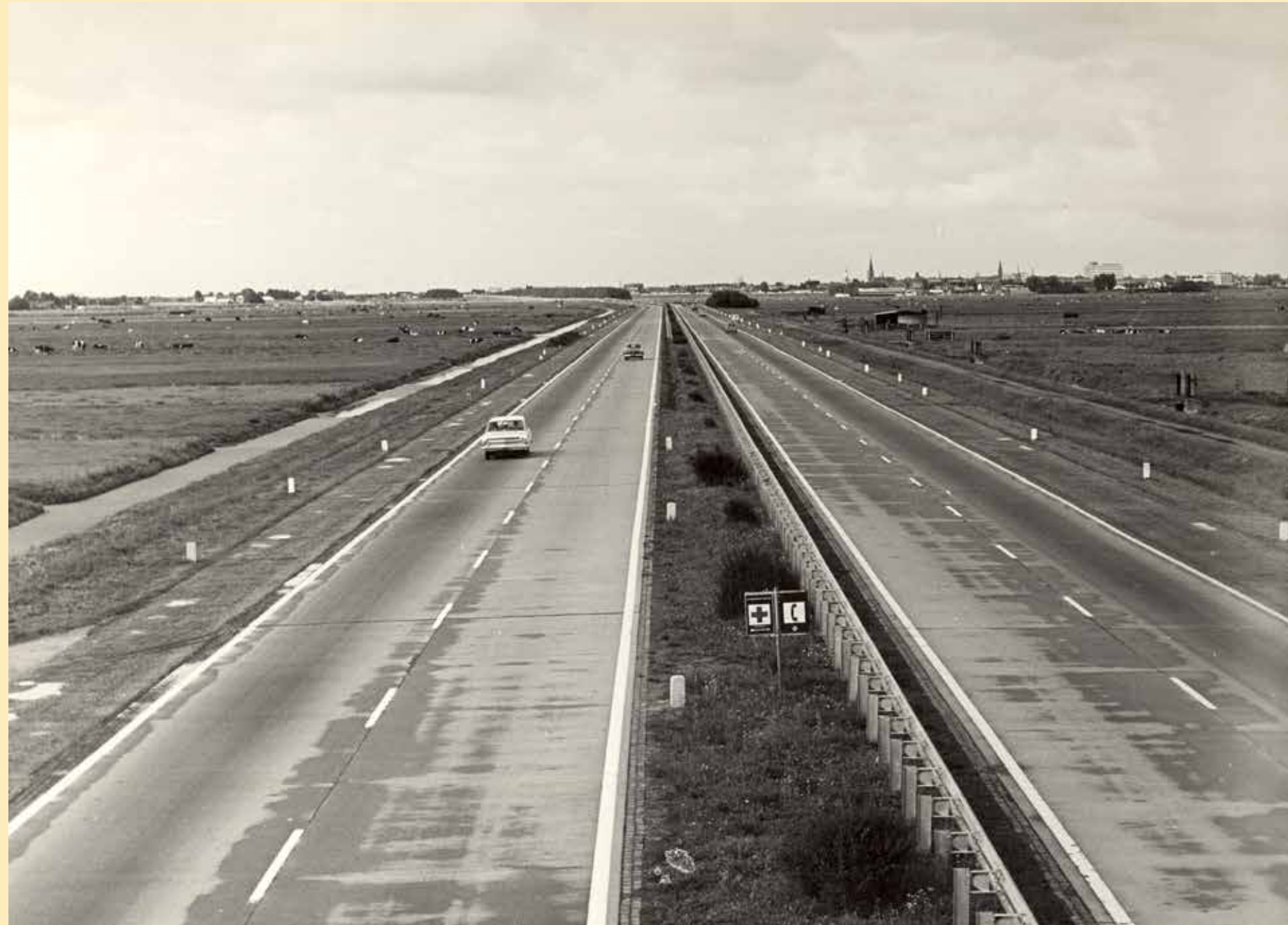
Rijksweg A4 gezien vanaf het viaduct aan de Kniplaan in zuidelijke richting in 1966
