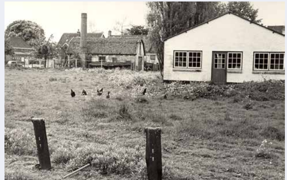
De achterzijde van de woningen aan de Koningin Julianaweg biedt in 1969 nog een zeer rustiek beeld met diverse kleine fabriekspanden, waaronder geheel rechts het pand van de pindarepenfabriek. Helemaal links zien we nog het schoolgebouw. (Bron: gemeentearchief Leidschendam-Voorburg).
