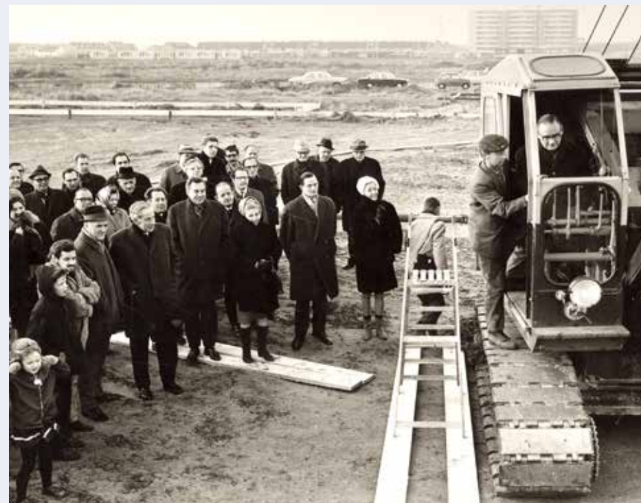
Burgemeester Kolfschoten in de graafmachine, verricht officieel de eerste werkzaamheden voor de bouw van het zwembad De Fluit in de Amstelveen. Vervaardiger Foto Hogenboom. Bron: gemeentearchief Leidschendam-Voorburg
