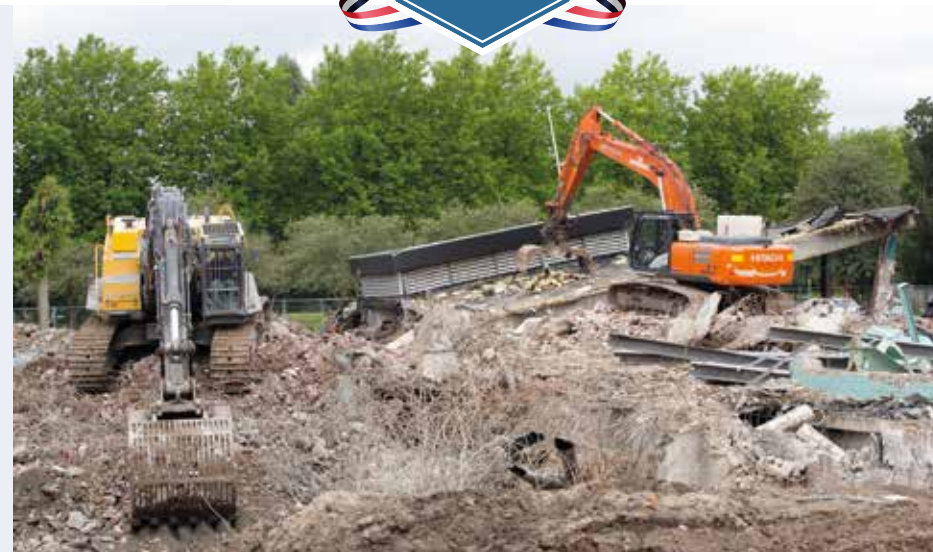
Sloopwerkzaamheden afbraak zwembad De Fluit 29 juli 2016. Bron: fotocollectie Idsard Bosman Na bijna vijftig jaar maakt de slopershamer een einde aan het eerste officiële zwembad van Leidschendam.
