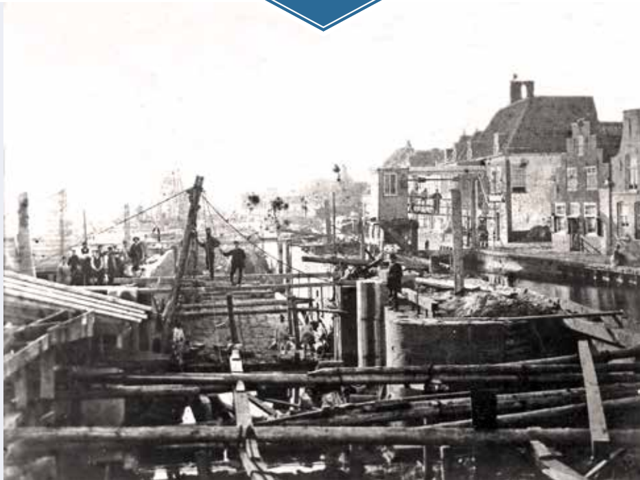
Bouw van het sluiscomplex bij Leidschendam, 1886. (Collectie Gemeentearchief Leidschendam-Voorburg)
