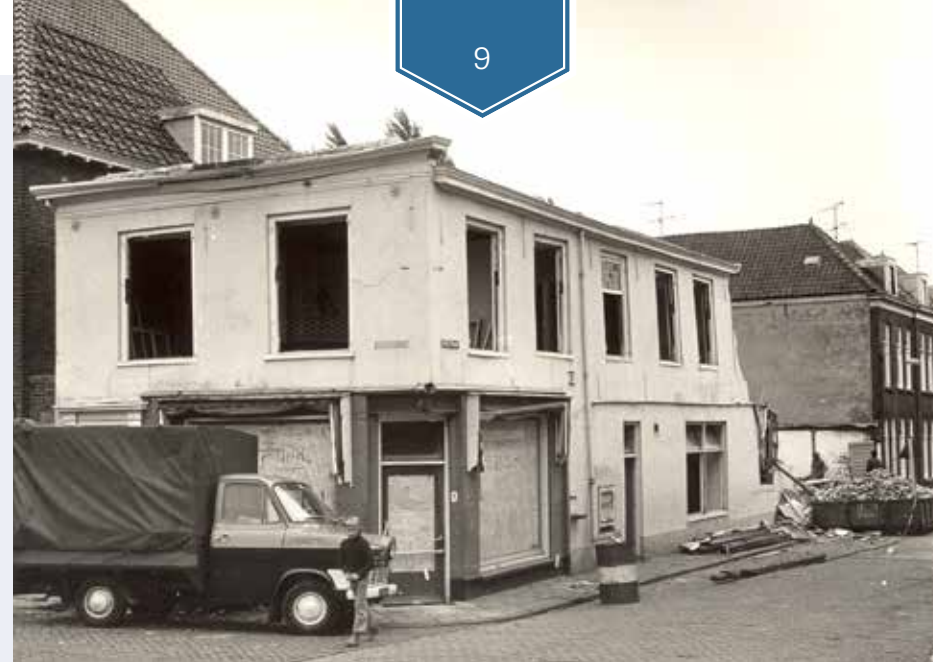
Afbraak van de voormalige bakkerswinkel van de familie Ten Hoopen op de hoek van de Venestraat - Leidsekade gezien vanaf de Noordelijke sluisbrug in 1976. (Foto: Gemeentearchief Leidschendam-Voorburg)
