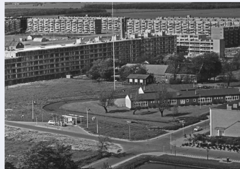
Gezicht vanaf de toren van het Neherlaboratorium op de wijk De Heuvel in 1964, met op de voorgrond de kruising van de Van Ruysdaellaan met de J.S. Bachlaan. Met links het Fina benzinstation en rechts de Protestants Christelijke lagere school. Links met daar boven de restanten van boerderij Op den Heuvel. Bron: gemeentearchief Leidschendam-Voorburg.
