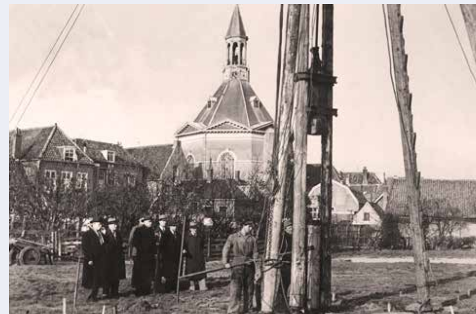
In 1949 wordt de eerste paal geslagen voor de bouw van 26 woningwetwoningen aan de Regthuisstraat en de Stompwijkse Achterweg, de latere Nieuwstraat. Bron: gemeentearchief Leidschendam-Voorburg
