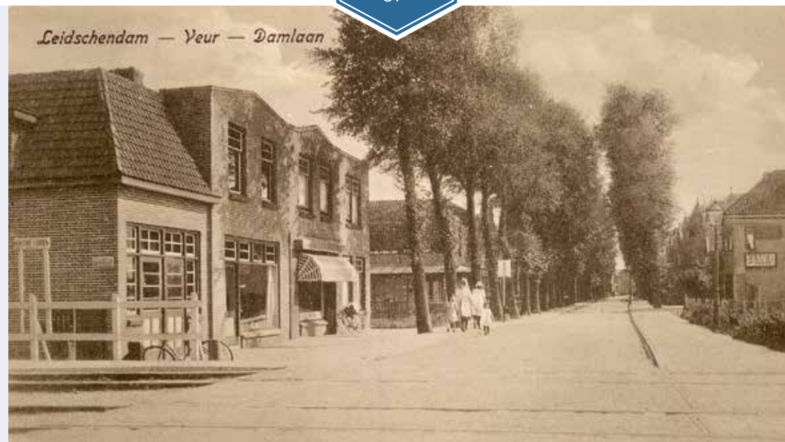
Foto uit 1925 met links de panden van de rijwielhersteller Van Haastreht en de slagerij van Vreeburg. Aan de zijgevel van de rijwielwerkplaats van Van Haastreht zien we naast het bord van het fietsenmerk Gazelle de verwijzing naar de opstaphalte van de Blauwe tram richting Leiden. (Foto: Gemeentearchief Leidschendam-Voorburg)
