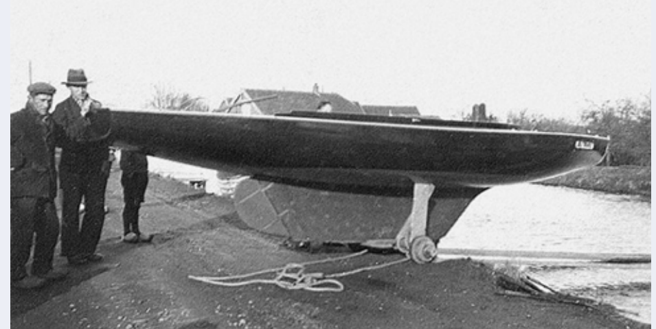
Het te water laten van een boot in de Stompwijksevaart. Hier nog met een onderstel met maar twee steunen.
