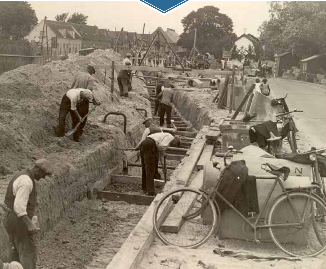
In 1934 werd in het kader van de 'werkverschaffing' riolering aangelegd in de Koningin Juliananweg, gezien naar de Romolenbrug. Links de plek waar nu het Kon. Julianaplein ligt. (Bron: fotocollectie gemeentearchief Leidschendam-Voorburg)
