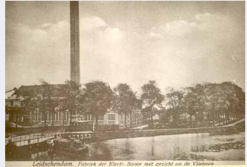
Electriciteitscentrale ZHESM spoorlijn Den Haag/Scheveningen-Rotterdam Hofpleinspoorlijn aan de Westvlietweg. Ansichtkaart, 1926.
