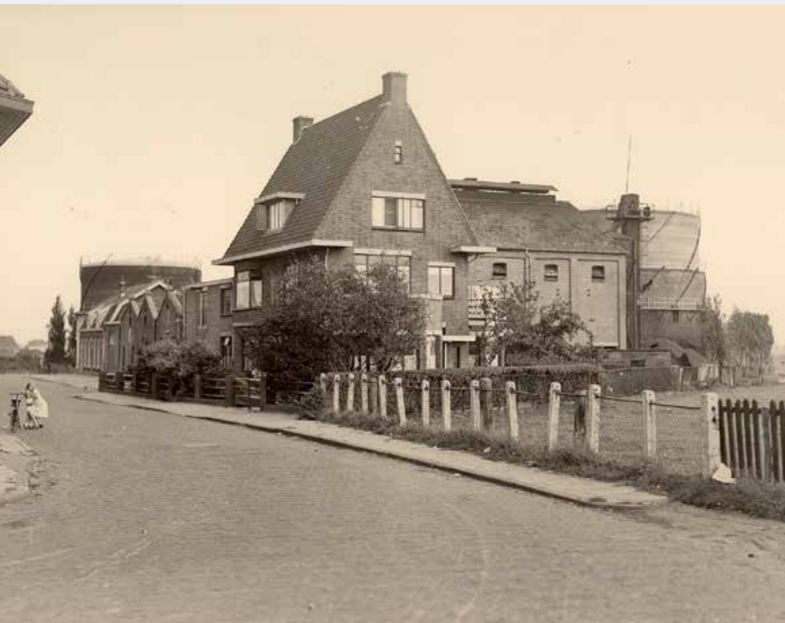
De gemeentelijke gasfabriek en het woonhuis van directeur H. Batelaan aan de Stompwijkse Achterweg (de huidige Nieuwstraat), gezien vanaf de hoek Vlietweg. In het woonhuis was later het politiebureau gevestigd. Foto uit 1950. (Bron: fotocollectie gemeentearchief Leidschendam-Voorburg)
