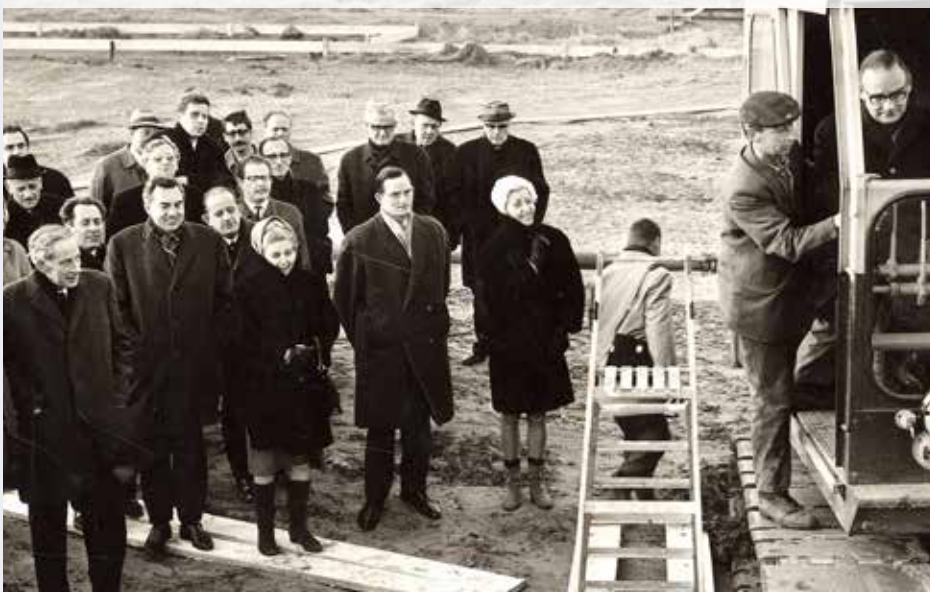
Eerste graafwerkzaamheden door burgemeester Kolfschoten voor zwembad De Fluit in 1969. (Foto van fotograaf Hogenboom, gemeentearchief Leidschendam-Voorburg)
